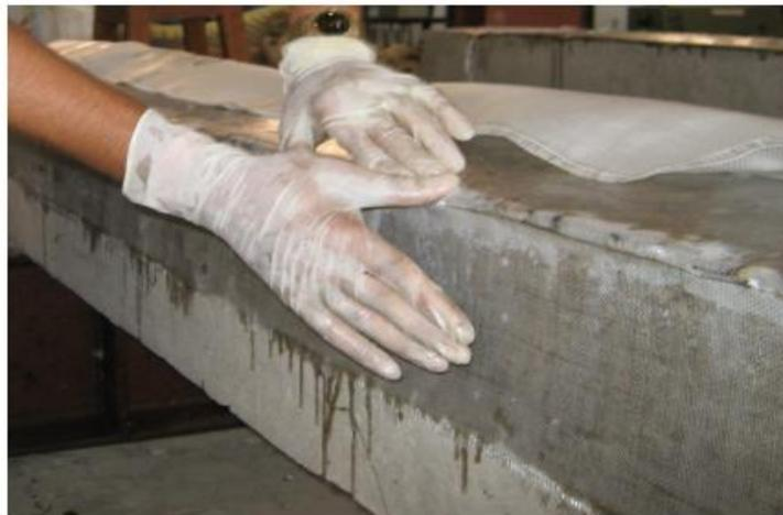
**FIG 6 FIXING OF GFRP SHEET ON THE BEAM**
